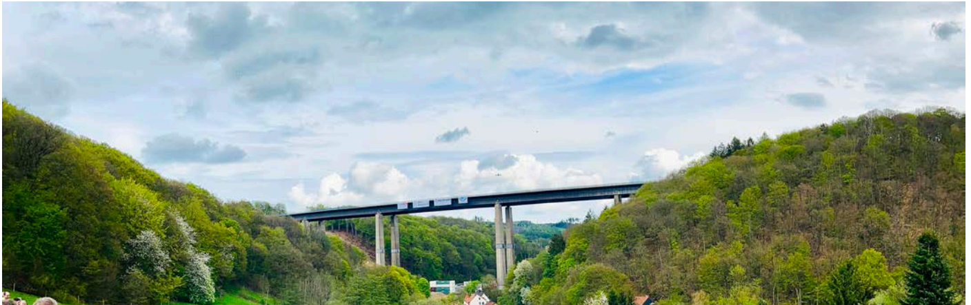
Die Brücke kurz vor der Sprengung
